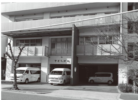
介護老人保健施設さくらがわ 外観
